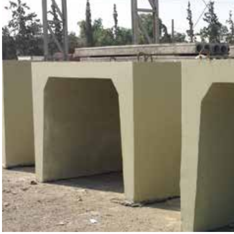
قاعدة موفق السلطي الجوية Mwaffaq Salti Air Force Base C-Bunkers
