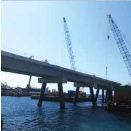
جسور ميناء الغاز المسال - العقبة LNG Terminal Girders - Aqaba
