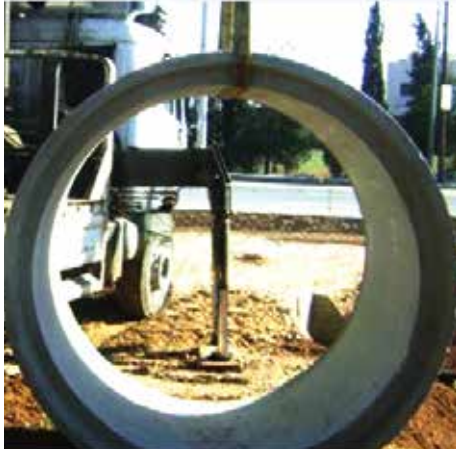
مشروع جر مياه الديسي Disi Water Conveyance
